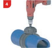
Effectuer le perçage du tube (hors charge) à l'aide d'un outil approprié.
