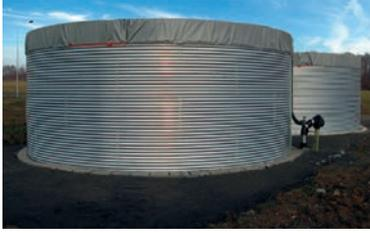
Cuve avec structure en panneau acier galvanisé avec liner en PVC ou DELAFLEX.
